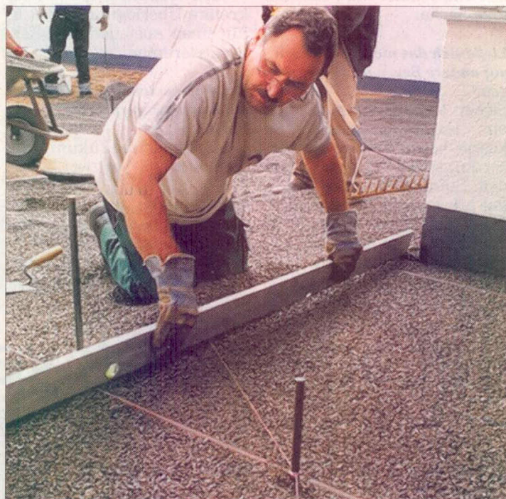
Ein ehrenamtlicher Helfer kontrolliert die Arbeiten am neuen Fallschutzboden im Innenhof der Kindertagesstätte.
